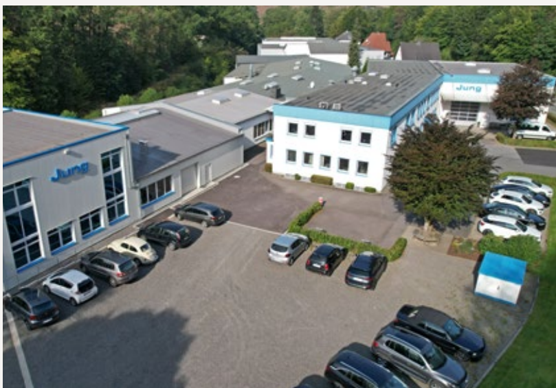
Am Standort Halver-Carthausen fertigt das Traditionsunternehmen Jung Präzisionsfedern sowie Stanz- und Biegeteile.
