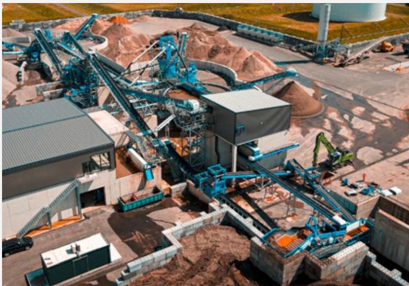
Die HDB Recycling GmbH realisierte in Hünxe eine innovative Anlage zur Nassaufbereitung von Bauschutt.
