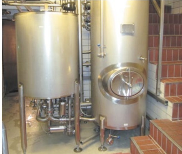
Die innovative CIP-Anlage führt zu geringeren Mischphasen von Wasser und Bier sowie zu einer eindeutigen Reduzierung der Abwasserfracht.
