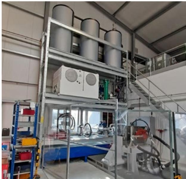
Die größten Einsparungen resultieren aus der Nutzung der Abwärme. Auf dem Bild ist der Wärmespeicher zu sehen.
