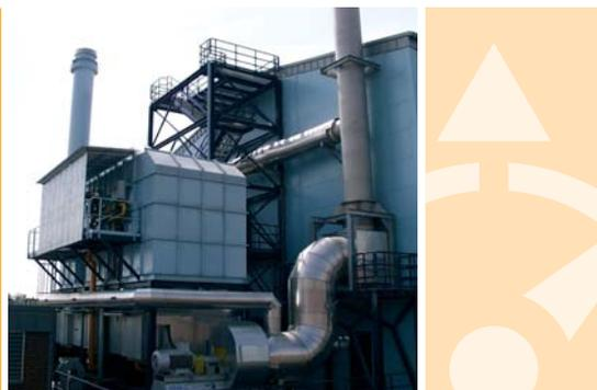
Aufgrund der Marktentwicklung entschied sich RHEINZINK im Jahre 2005, die Kapazitäten zu erhöhen und eine neue Oberflächenbehandlungsanlage inklusive einer regenerativen Abluftreinigung (RNA) zu errichten. Das neue Vorbewitterungsverfahren ist vergleichbar mit dem der alten Anlage, jedoch wesentlich umweltfreundlicher und ressourcenschonender durch die gezielte Nutzung der Wärmeenergie aus der RNA. Das neue Abluftreinigungsverfahren ist weltweit einmalig.
